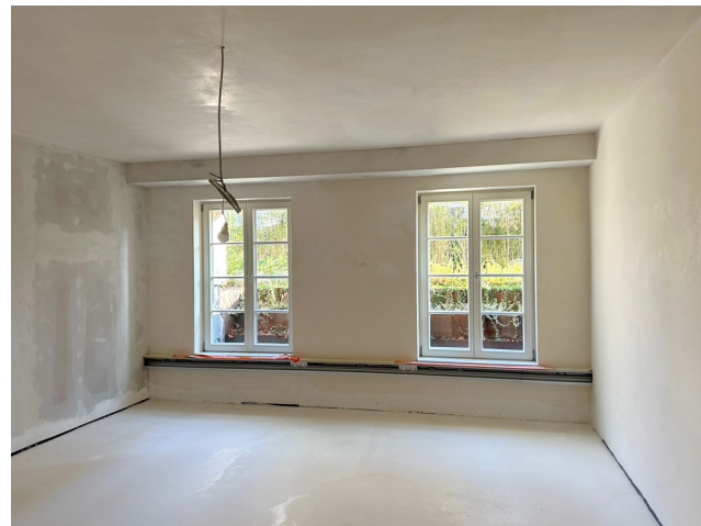
Erstbezug im Garden Office (HZD 151, Souterrain)
