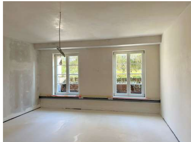
Erstbezug im Garden Office (HZD 151, Souterrain)
